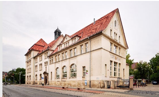
Denkmalgeschützte J.-F.-Kennedy Schule Braunschweig
