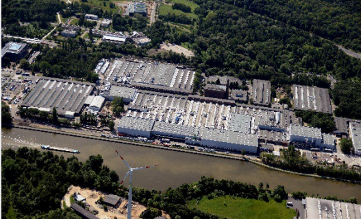
Clarios - Ausbau AGM-Produktion „Werk Hannover“
