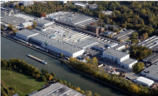
Ausbau Batteriewerk Hannover Neubau von 5 Hallenkomplexen
