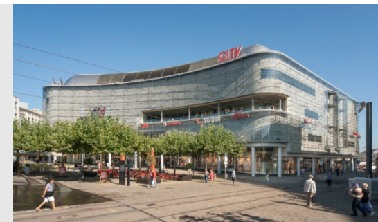
City Point Kassel Neubau
