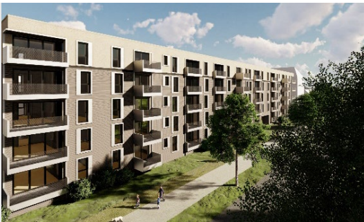
„Petershauser Briel“ Konstanz MOD/INST / Aufstockung / Neubau
