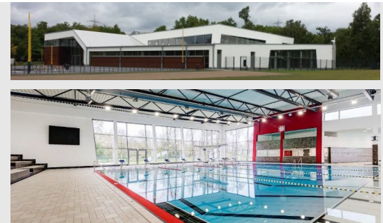
Sportbad Thurmfeld in Essen Neubau
