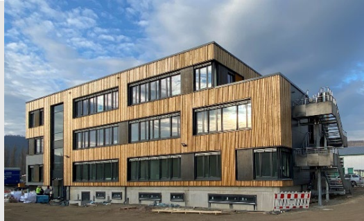
BSS Betriebshof Stadtwerke Springe Neubau Bürogebäude und Betriebshalle
