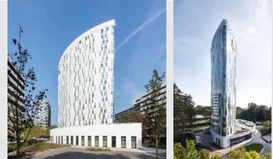
Hotelgebäude CITY NORD Hamburg Neubau
