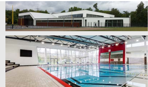
Sportbad Thurmfeld in Essen Neubau
