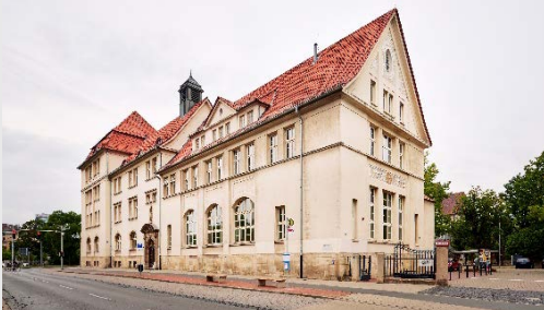
► Denkmalgeschützte J.-F.-Kennedy Schule Braunschweig
