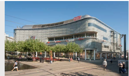
City Point Kassel Neubau
