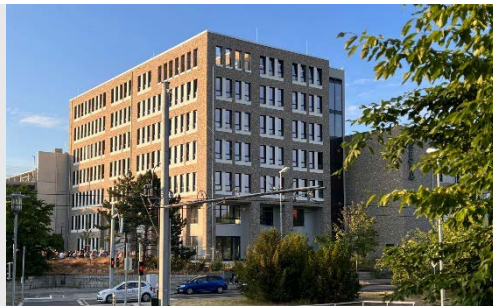
Bürogebäude i-Serv – Haus A „Quartier Berliner Straße“ Braunschweig _ Neu-/Ausbau
