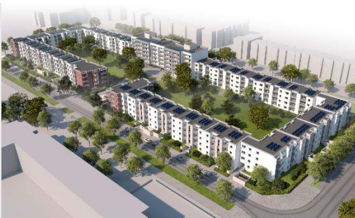
► „SAGA Große Holl“ Hamburg MOD/INST/Energetische Sanierung
