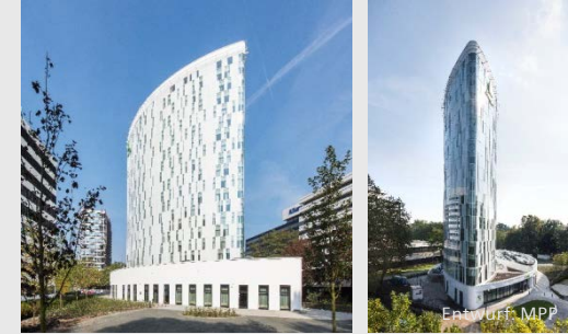
Hotelgebäude CITY NORD Hamburg Neubau
