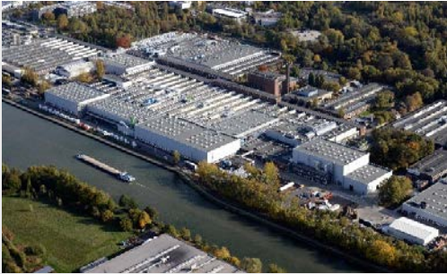
► Clarios - Ausbau AGM-Produktion „Werk Hannover“
