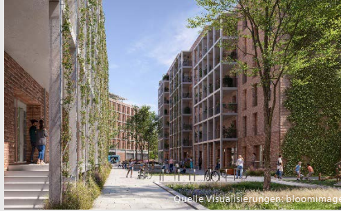
„Hafenbahnhof“ Stadtquartier Hamburg - Wilhelmsburg _ Neubau
