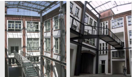
Com@Com Center Dessau Umnutzung denkmalgeschütztes Gasgerätewerk
