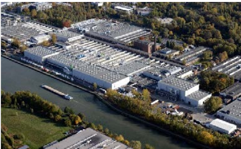
► Ausbau Batteriewerk Hannover Neubau von 5 Hallenkomplexen
