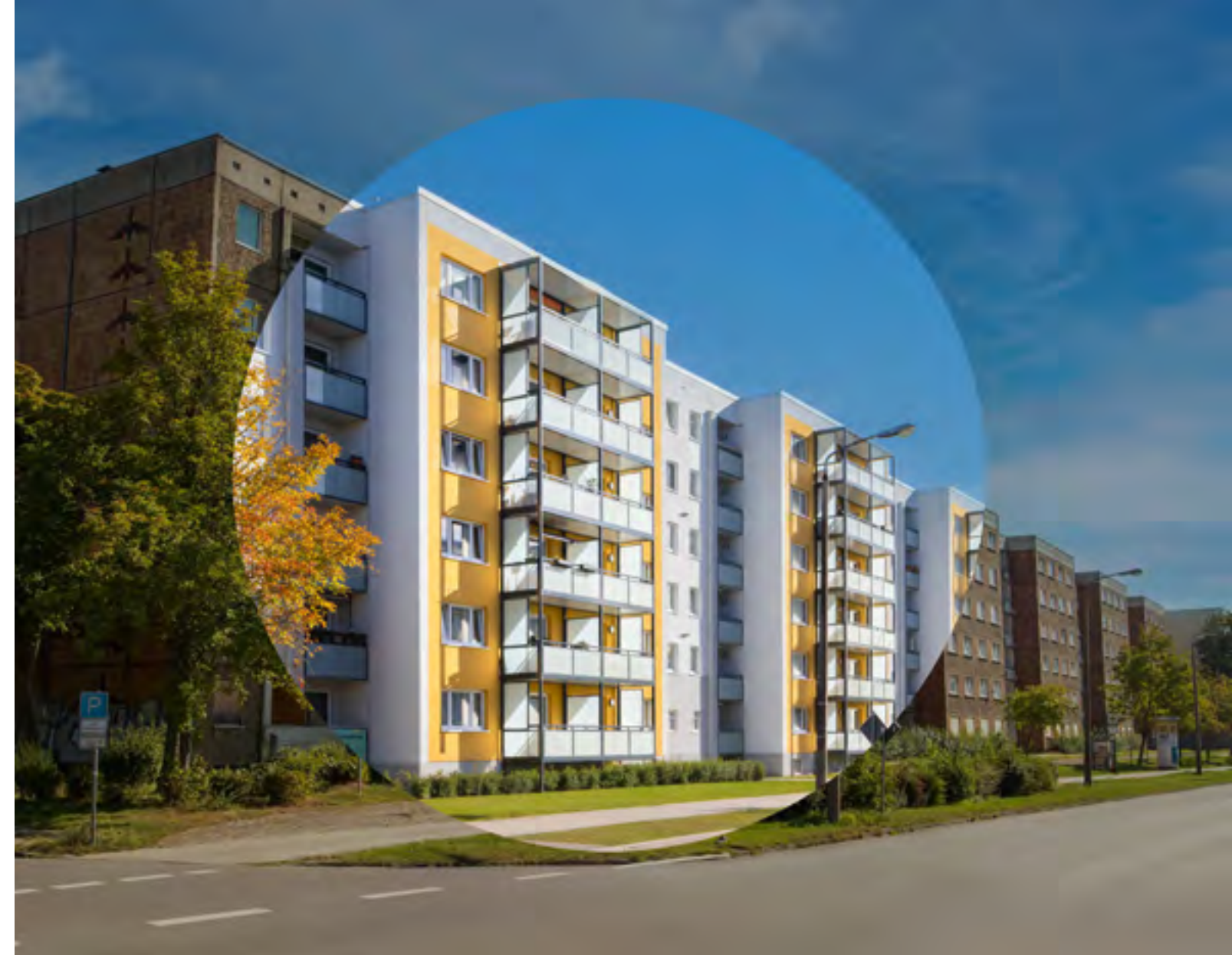
Wohngebäude, Greifswald, 10.900 m², umfangreiche Sanierung und Umbau
