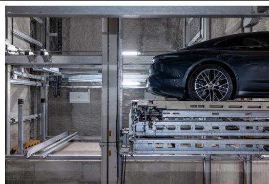
Bild 2: Das Auto wird mit dem Regalbediengerät an seinen Stellplatz befördert.
