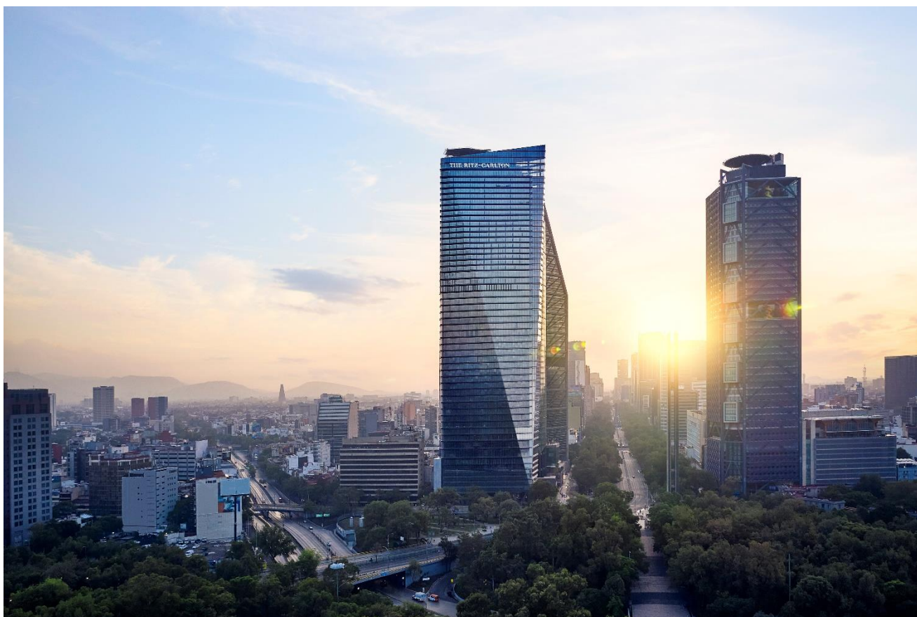
Der neue Turm Chapultepec Uno beherbergt Büros, Wohnungen und Zimmer der Edel-Hotelmarke Ritz Carlton / Foto: Edgardo Contreras, Luis Sánchez Núñez de Cáceres
