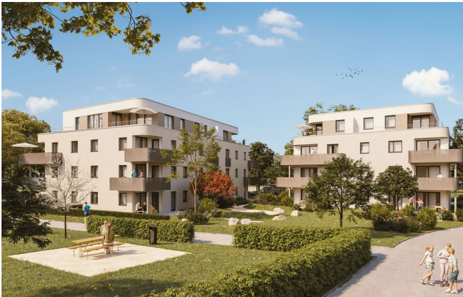
Südwestansicht der Wohnhäuser Westende 61a und 61b, die sich gegenüber des öffentlichen Spielplatzes befinden.
