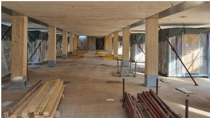
Dipl.-Ing. (FH) Kai Vahle ist Projektleiter bei der HESS TIMBER GmbH, die das Holz-Tragwerk herstellt: Brettschichtholz-Stützen, Brettschichtholz-Träger und eine Holz-Beton-Verbunddecke aus 16 cm Brettspertholzdecken mit 10 cm Aufbeton. Zur Verwendung kommt
