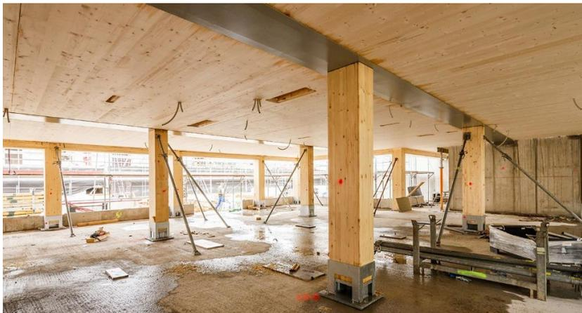
Eine „interessante“ technische Herausforderung war auch das Tragaster der Bestandskonstruktion. Von Fritsch: „Während das Bestandsgebäude große Spannweiten von bis zu 15 Metern aufweist, die für
