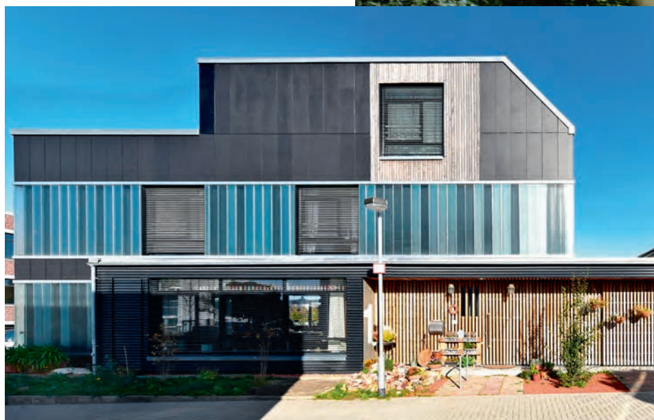
Neubau aus alten Materialien In Hannover steht das Recyclinghaus des Bauträgers Grundlach. Für den Bau wurden über 50 Prozent Secondhand-Baumaterialien wie Türen und Ziegel aus einem alten Bauernhaus verwendet.
