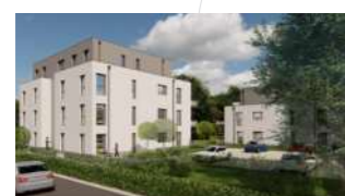
KÖNIGSWINTER Architektur: ALHO Systembau GmbH
