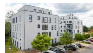
ASCHAFFENBURG Architektur: Koschany + Zimmer Architekten
