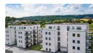
FAMILIENHEIM MOSBACH Architektur: ALHO Systembau GmbH
